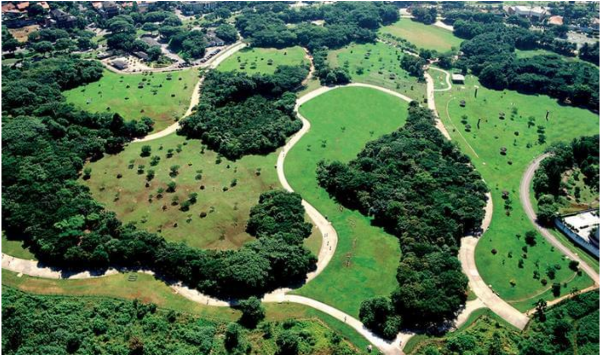
Figura 39- Vista Aérea do Parque Villa-Lobos,SP
