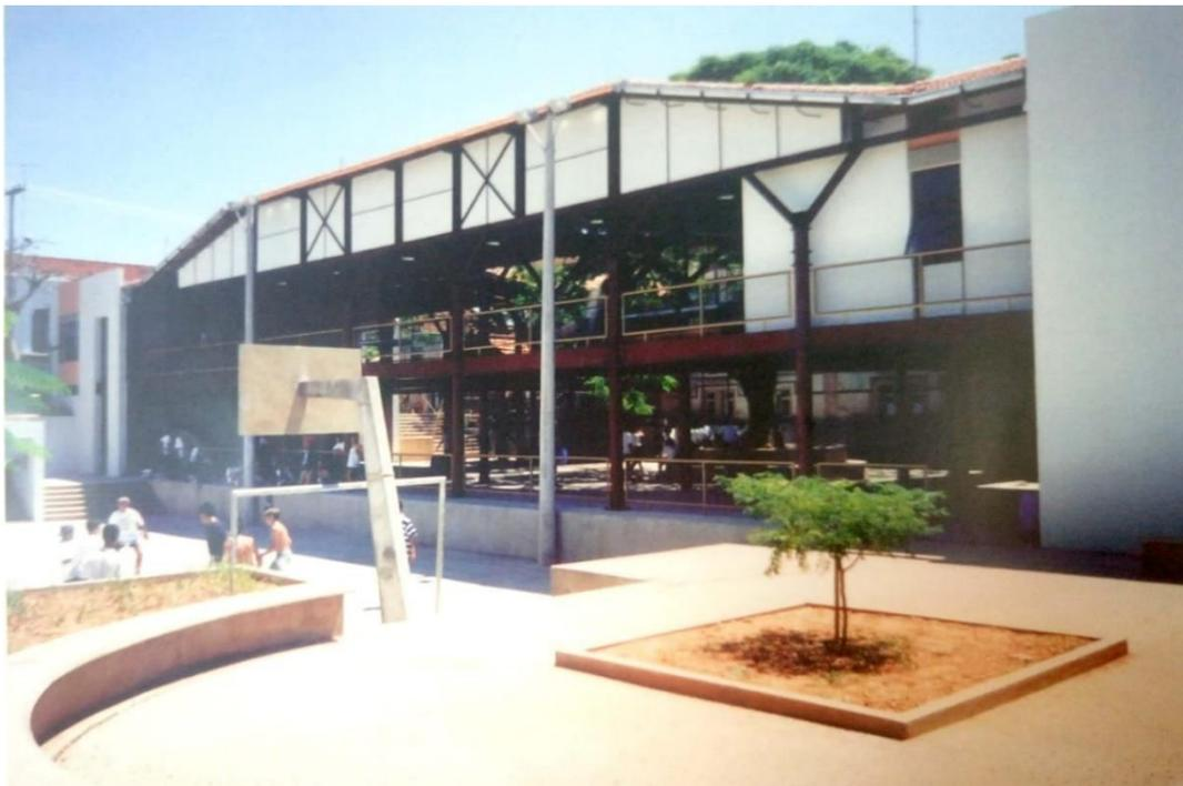
Figura 8: Fachada posterior da nova edificação em estrutura metálica coberta com telhas de barro, interpretando os antigos galpões. Chapas lisas traduzem em novas formas os lambrequins de outrora. Fonte: CÔRREA, 1998.
