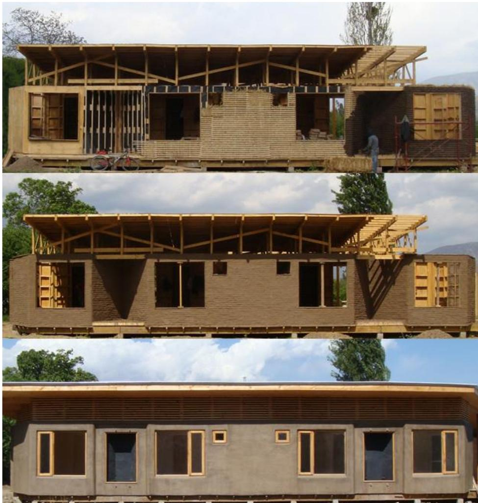
Figura 8. Processo de construção em uma das fachadas.
