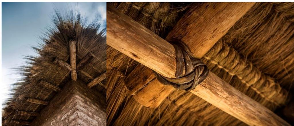
Figura 12. Telhado, tecido à mão com fibras de ichu..
