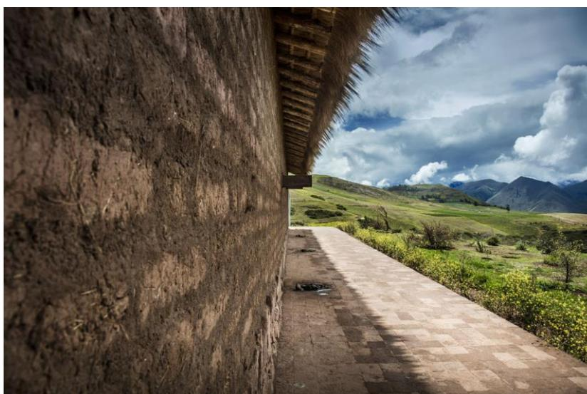
Figura 14. Parede externa, construída com misturas de terra.
