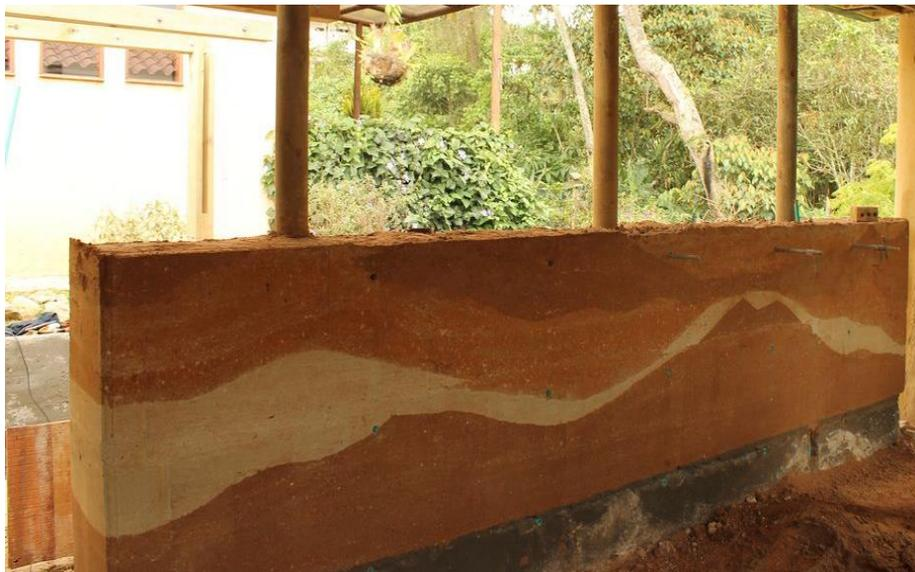
Figura 48. Modelo de parede de taipa de pilão.
