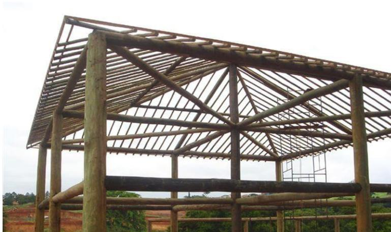
Figura 49. Exemplo de estrutura em madeira de reflorestamento.
