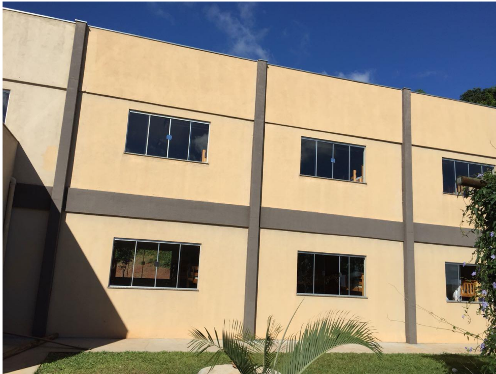
Figura 28: Vista exterior dos Dormitórios Masculinos. Tirada em 21/05/18, às 12h24min, via celular, acervo do autor.
