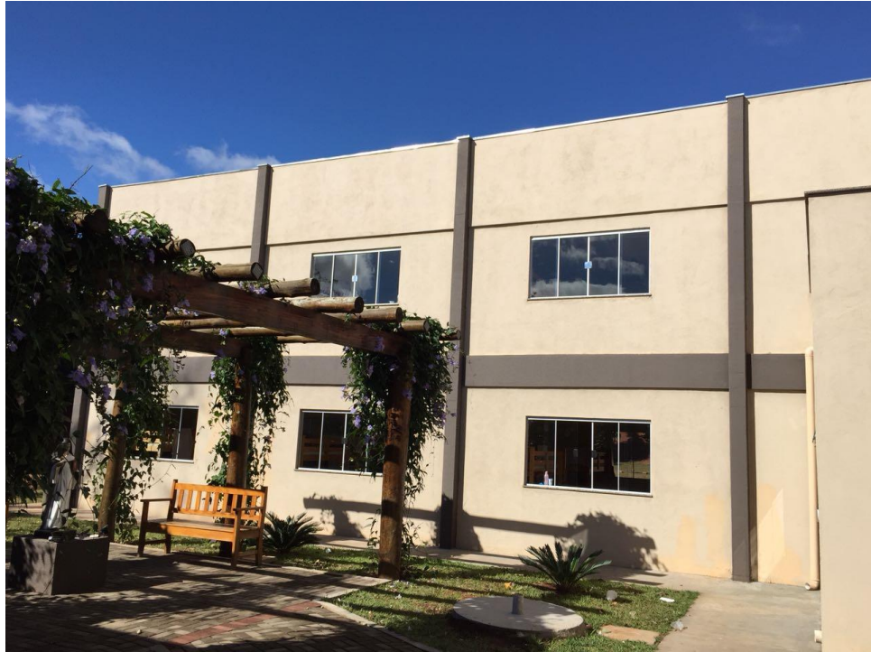
Figura 27: Vista exterior dos Dormitórios Femininos. Tirada em 21/05/18, às 12h23min, via celular, acervo do autor.
