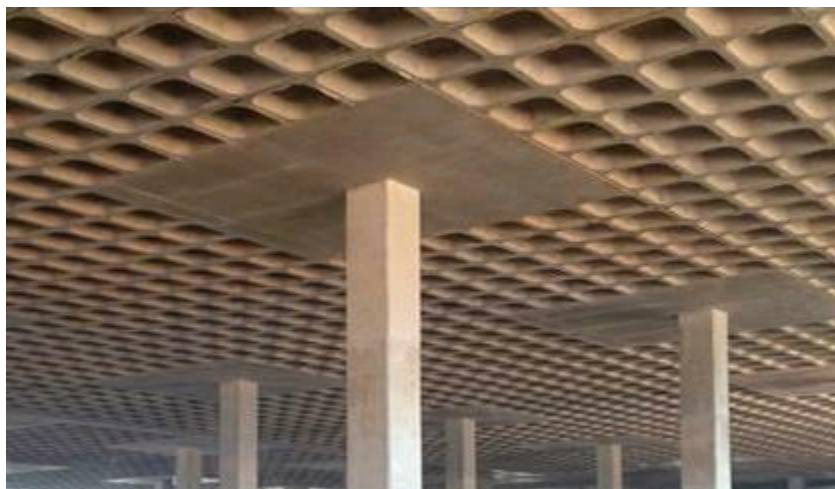
Figura 35: Capitel formado em volta de um pilar de sustentação.
