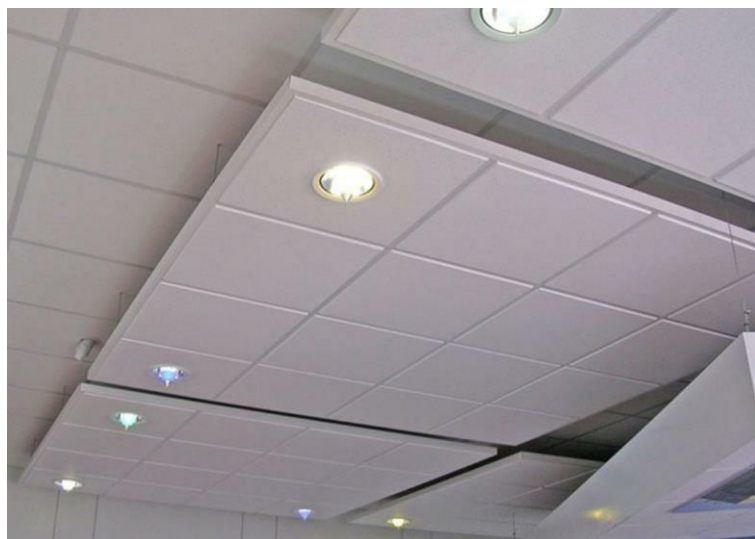
Figura 43: Forro mineral instalado com estrutura metálica e tirantes de arame galvanizado.
