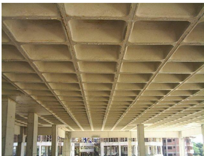
Figura 34: Laje Nervurada
