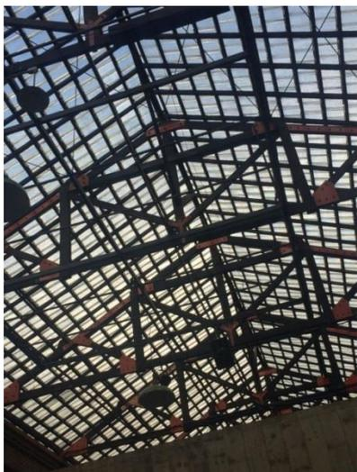
**Figura 185** – Detalhe Cobertura do galpão do Teatro – Tesouras de madeira com enxertos Metálicos e telhas translúcidas (vidro temperado). Tirada em 24/03/18, via celular, acervo do autor.
