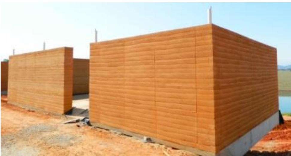
**Figura 16** – Alvenaria de Taipal de Pilão. Fonte: sustentarq.com.br
