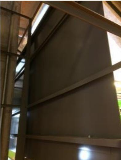
**Figura 150** – Estrutura de fixação dos painéis da sala Números e Curiosidades (2). Tirada em 25/03/18, às 11h44min, via celular, acervo do autor.
