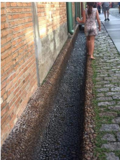
**Figura 206** – Canaletas para escoamento de água pluvial revestidas de pedra roliça. Tirada em 24/03/18, via celular, acervo do autor.
