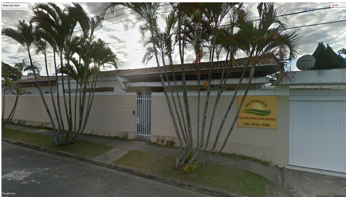
Figura 11 Fachada da instituição Sol Nascente
