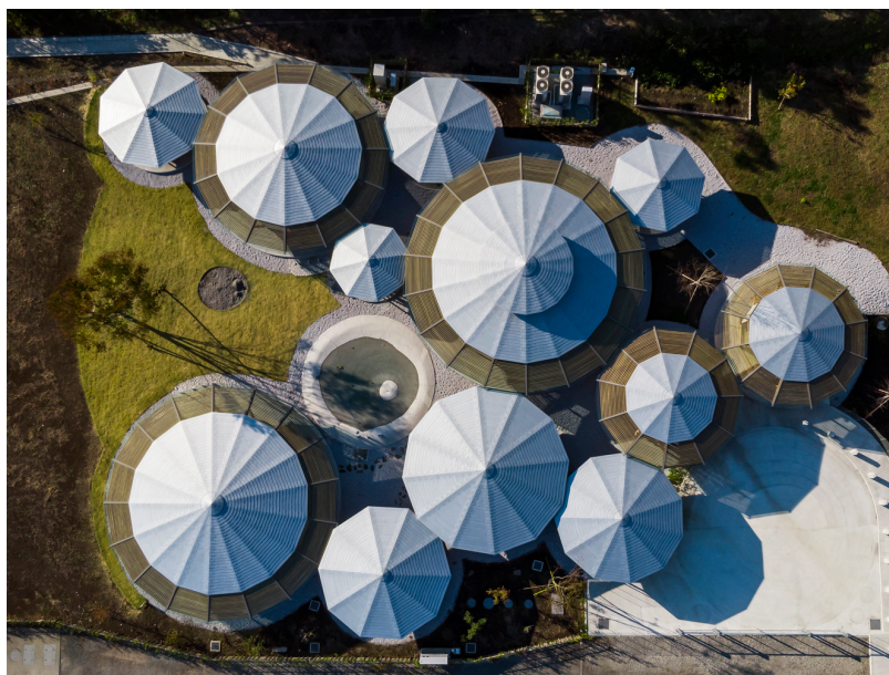
Figura 59 Vista aérea da Creche MUKU
