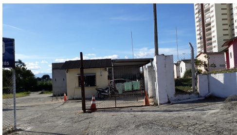
Figura 84 Vista frontal do terreno de implantação
