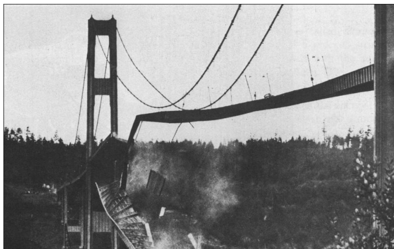
Figura 2 - Ponte de Tacoma Narrows durante vibração induzida pelo vento
