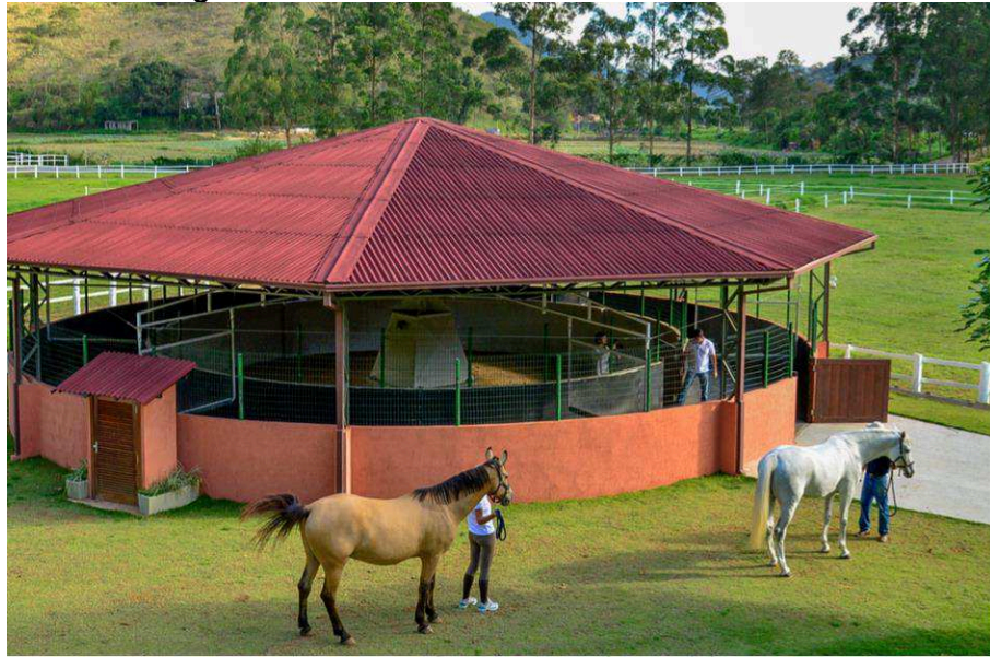
Figura 5 - Estrutura de concreto - Coberta.
