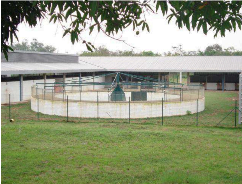
Figura 2 - Estrutura no local
