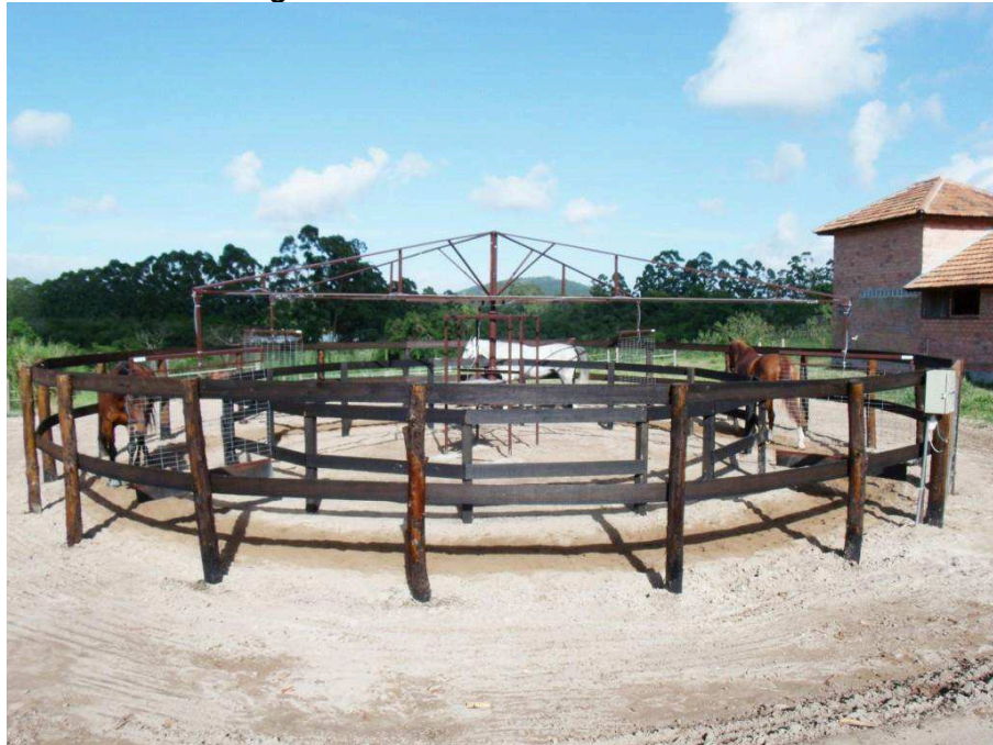
Figura 4 - Estrutura de madeira
