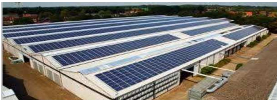
Figura 26 - Galpões de armazenamento utilizando energia fotovoltaica
