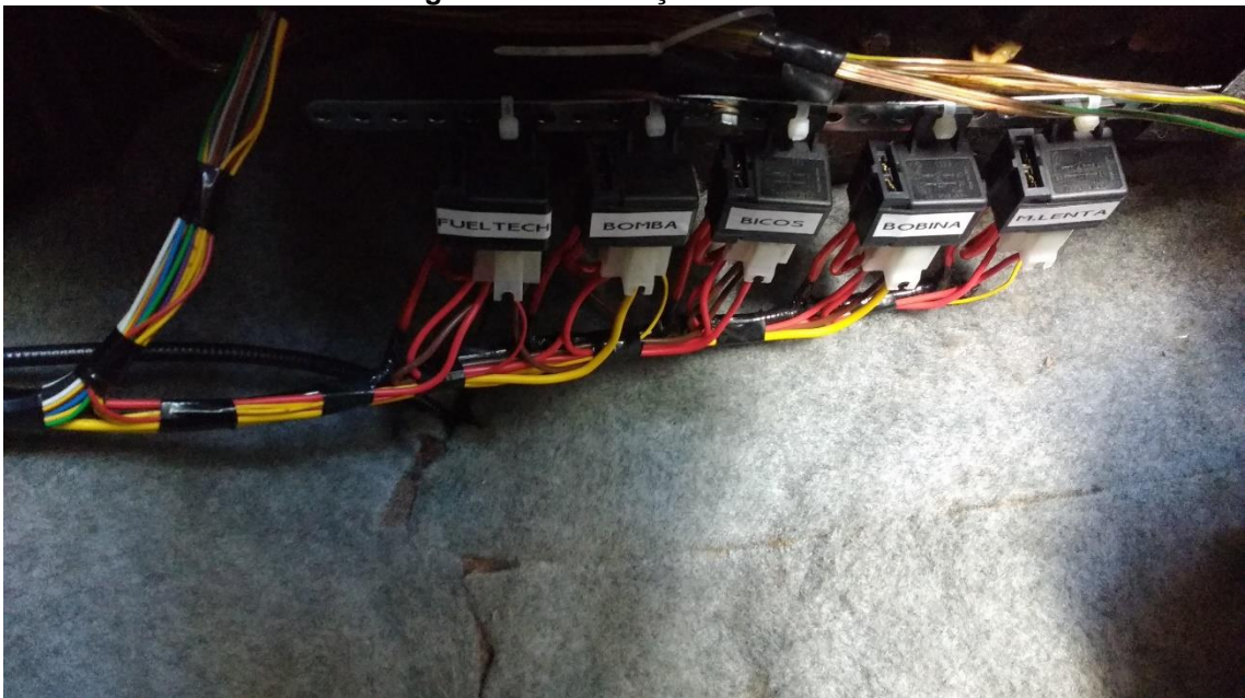
Figura 38 – Instalação dos Reles
