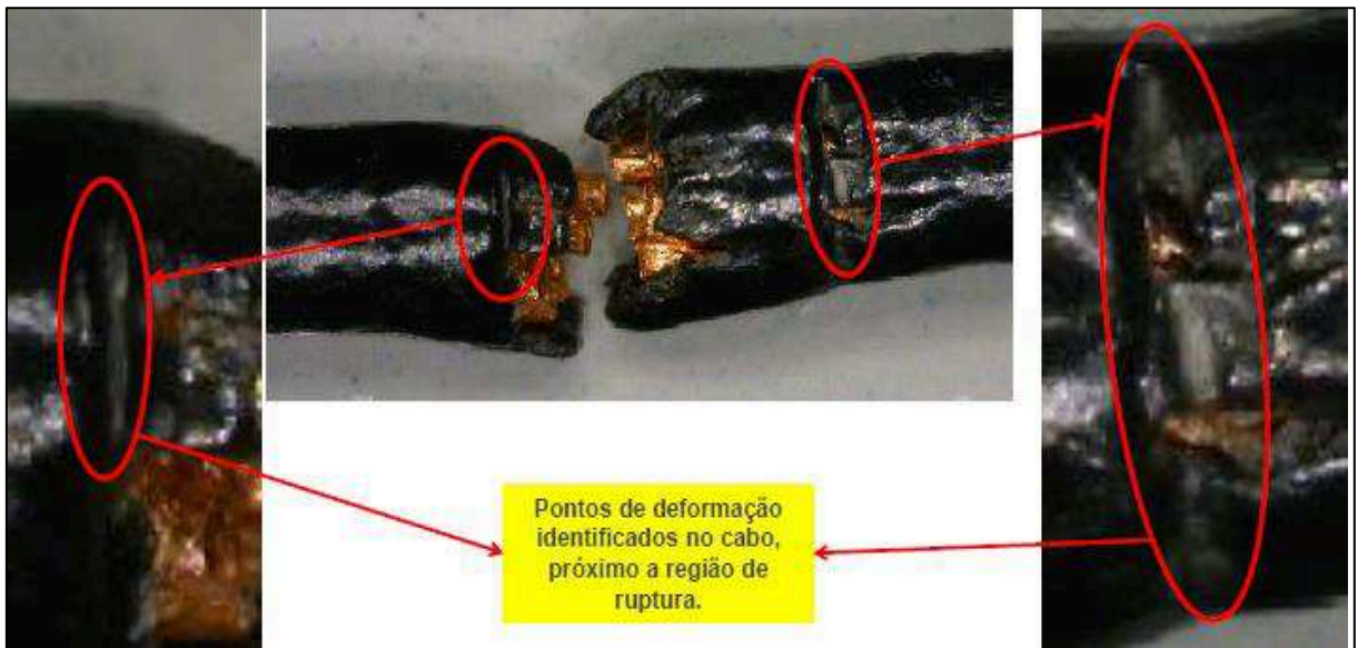
Figura 5 - Região do rompimento
