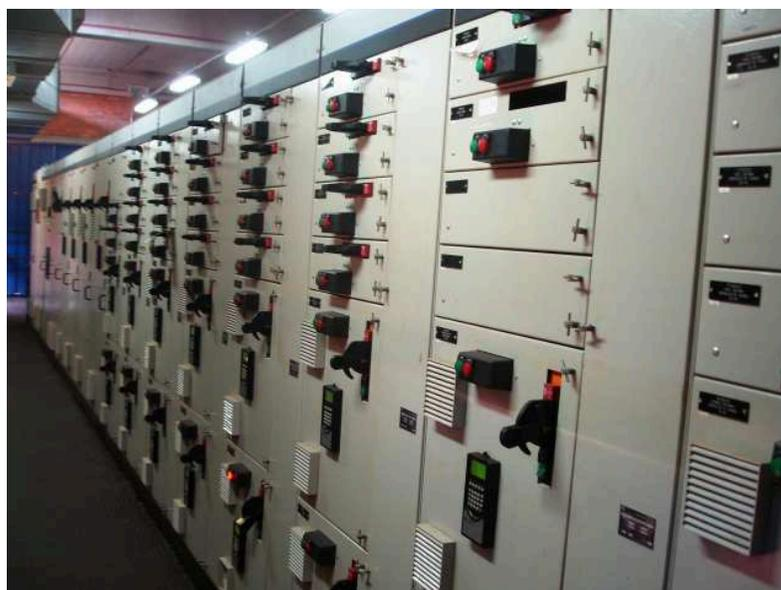
Figura 9 – Sala de painéis elétricos – CCMI recepção, preparo e extração (cortesia: Cabrera Energética)
