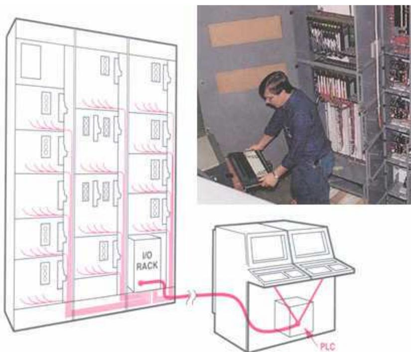
Figura 16 – Configuração de instalação de CCM convencional com interligação via cabo de rede e acionamento com IHM (cortesia: Rockwell Automation)
