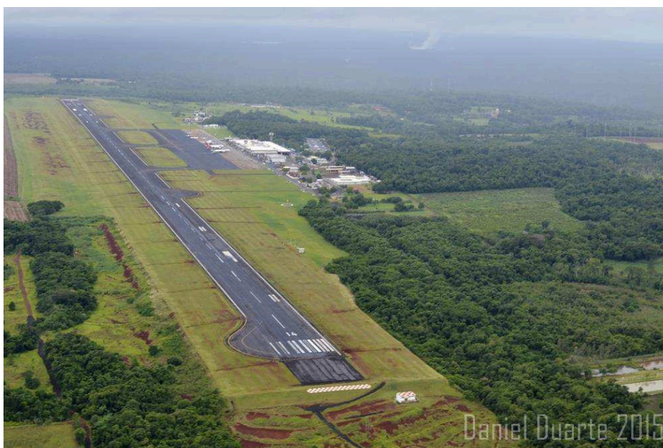
Figura 6 – Atual pista de pousos e decolagens do Aeroporto Internacional de Foz do Iguaçu (Foto: Daniel Duarte)
