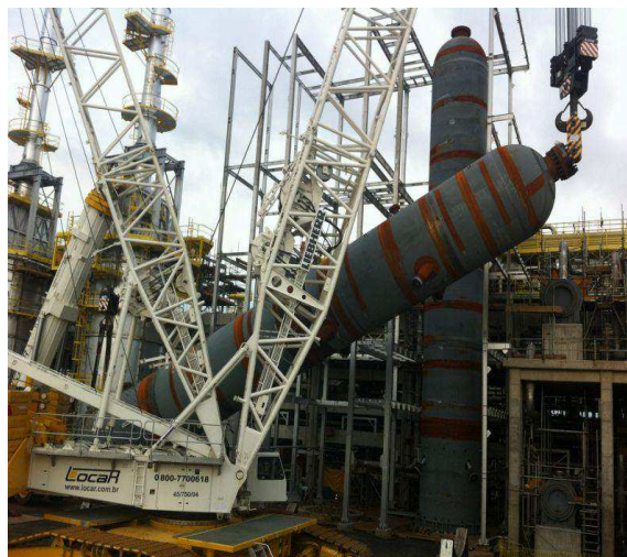
Fig.3 – Içamento do Reator na Replan
