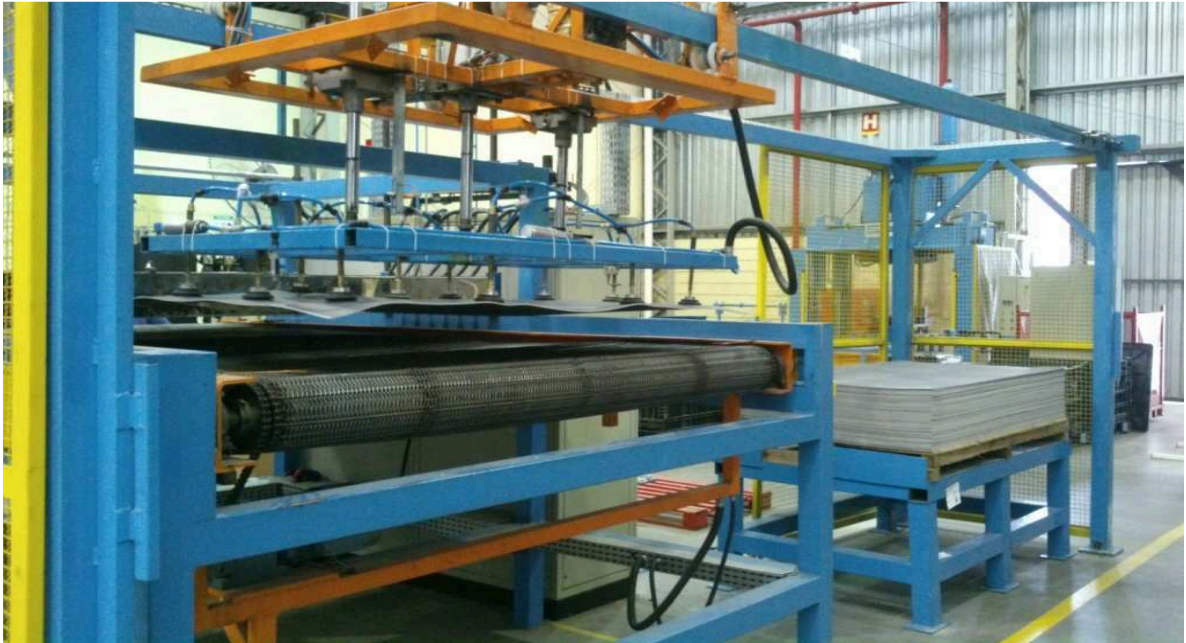
Figura 33 – Depois da implantação do sistema de transporte automatizado
