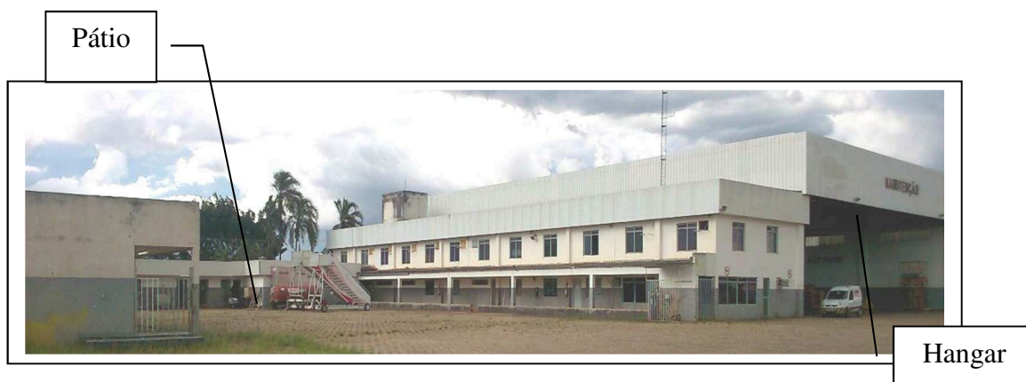
Figura 10: Fotos das instalações de manutenção na área denominada como lotes N°19 e 20.
