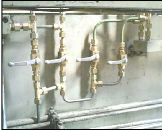
Figura 22 – Válvulas de esfera (após melhoria). Fonte: Empresa estudada.
