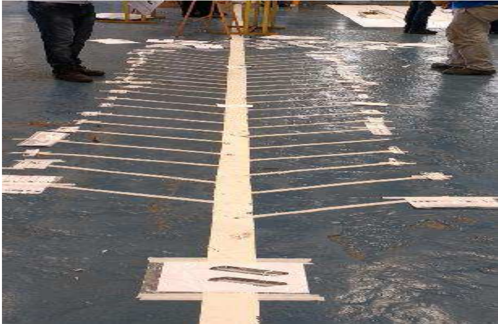
Figura 2 – Construção do Fishbone .
