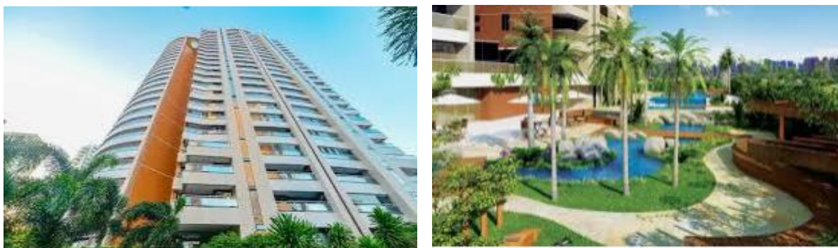
Figura 6 – Edifício Paço das Águas em Fortaleza, CE Fonte: http://fortaleza.achoumudou.com.br/
