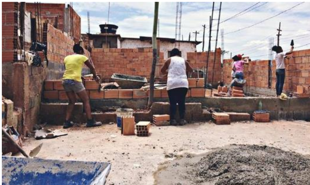
Figura 1: Canteiro de Obras Familiar
