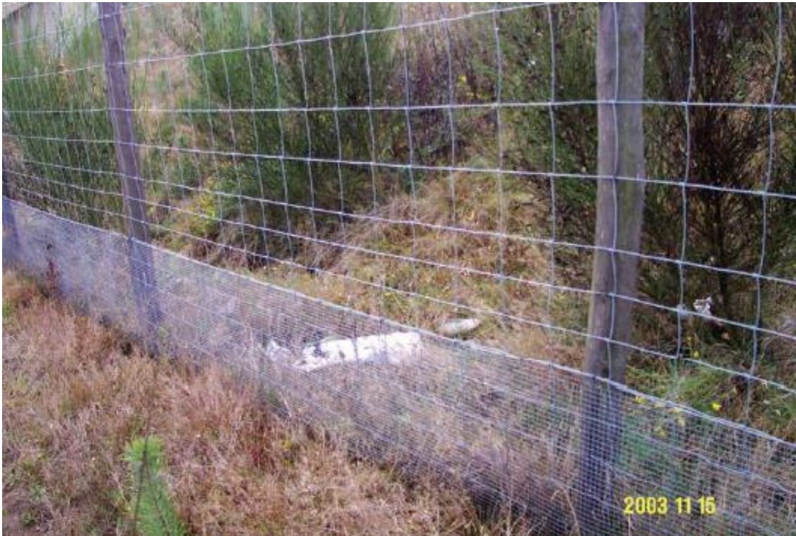
Figura 24: Exemplo de cerca com material para mamíferos de pequeno e médio porte emendado a material de cerca de grandes mamíferos.
