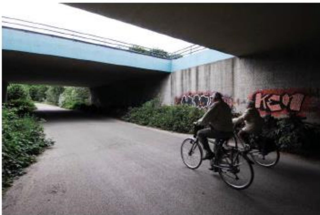
Figura 9: Exemplo de passagem inferior multiuso.
