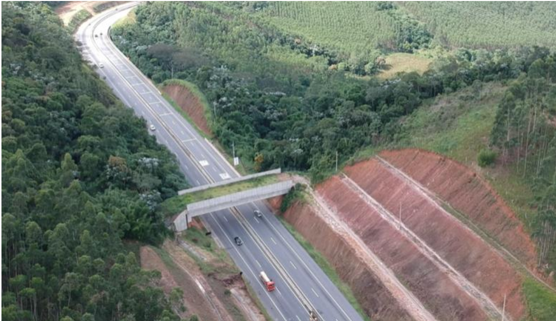
Figura 13. Viaduto de fauna sobre a Rodovia dos Tamoios, em Paraibuna – SP.
