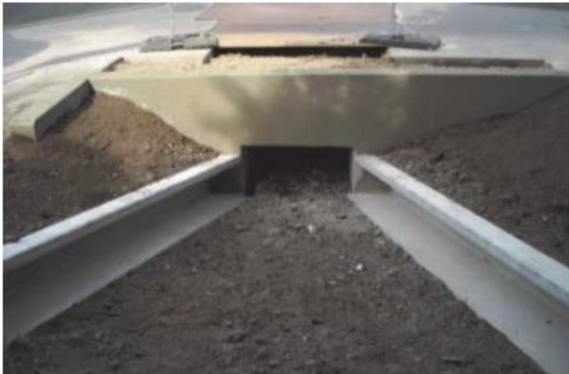
Figura 10: Exemplo de túnel para herpetofauna.
