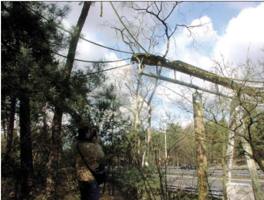
Figura 17: Exemplo de passagem em estrutura constituída por madeira e cordas.
