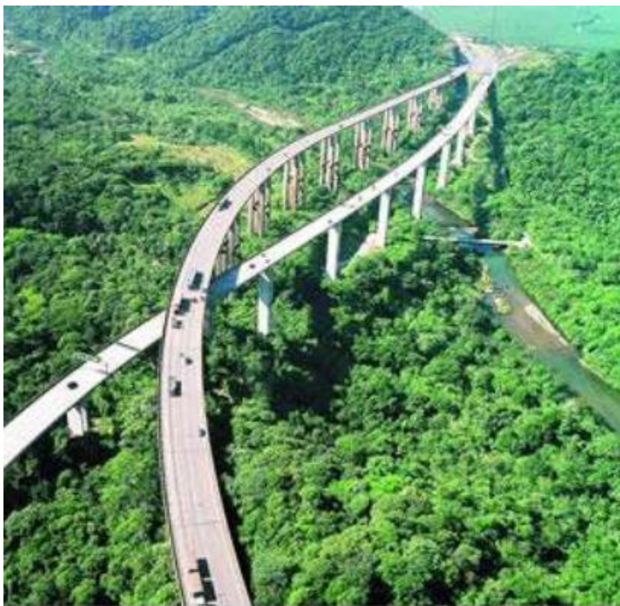
Figura 15: Rodovia elevada na SP-160, Rodovia dos Imigrantes, Brasil.
