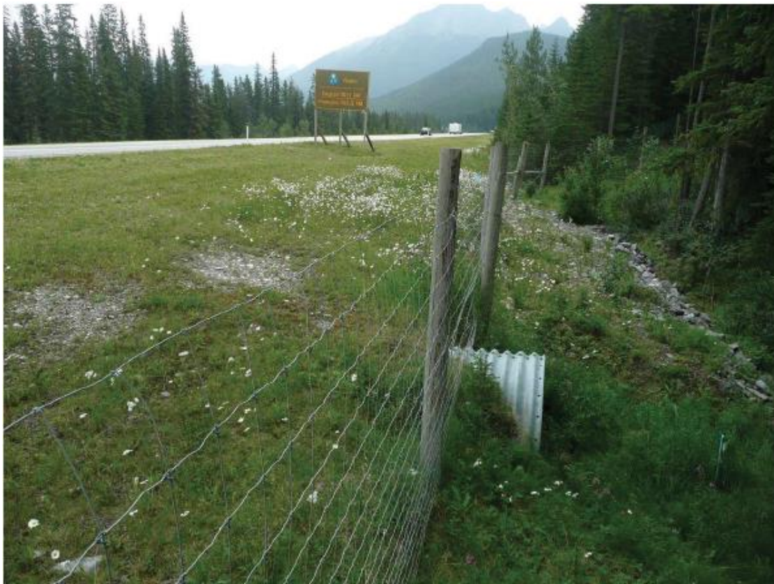
Foto 23: Exemplo de cerca guia e passagem subterrânea.
