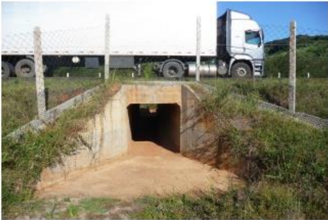
Figura 7: Exemplo de passagem de fauna do tipo caixa seca.
