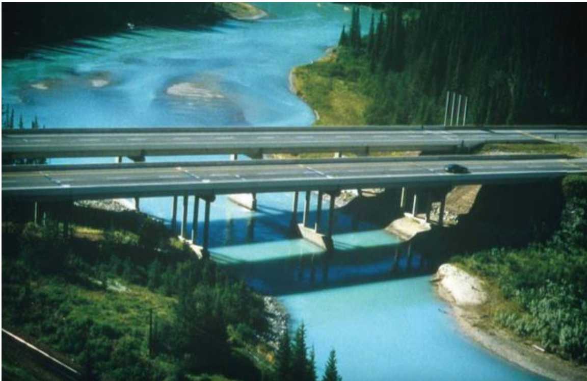
Foto 19: Exemplo de ponte projetada para conservar curso d'água.
