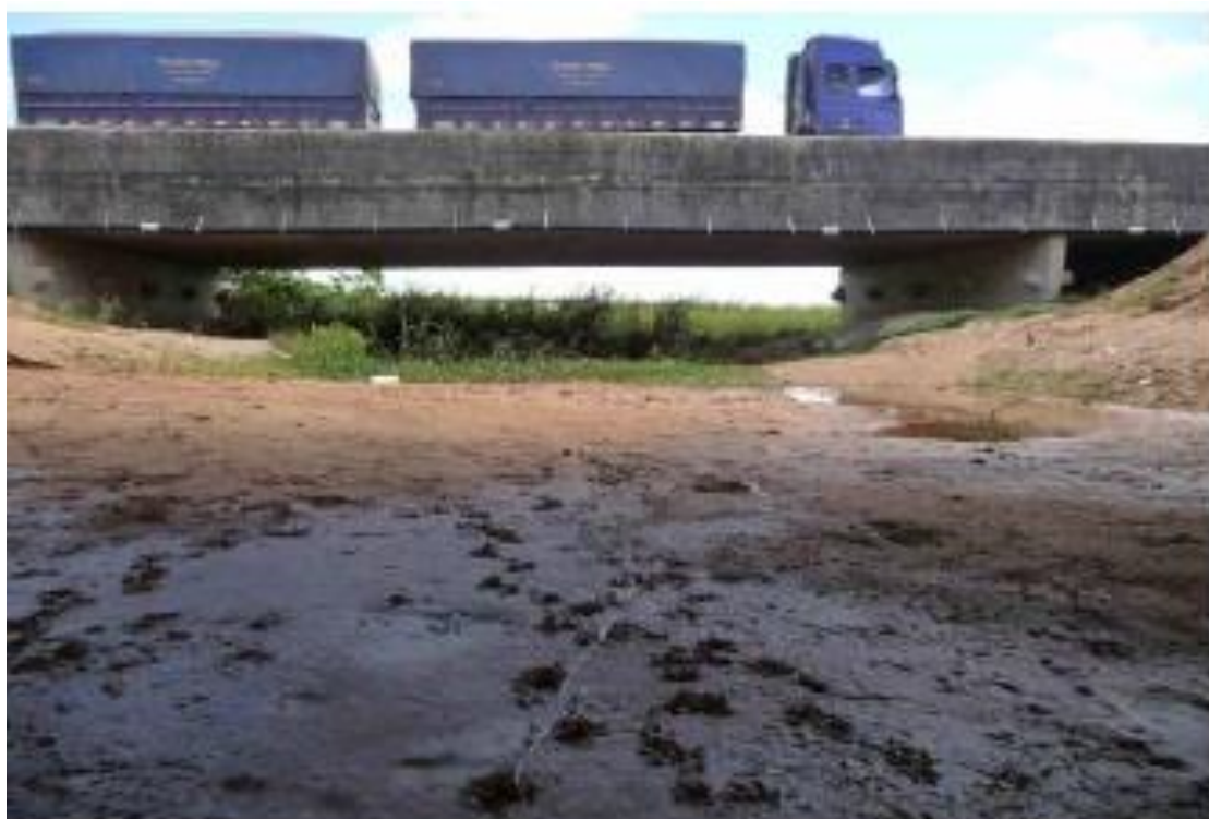
Foto 20: Exemplo de Pontilhão em BR 392/RS, com laterais secas para passagem de fauna.
