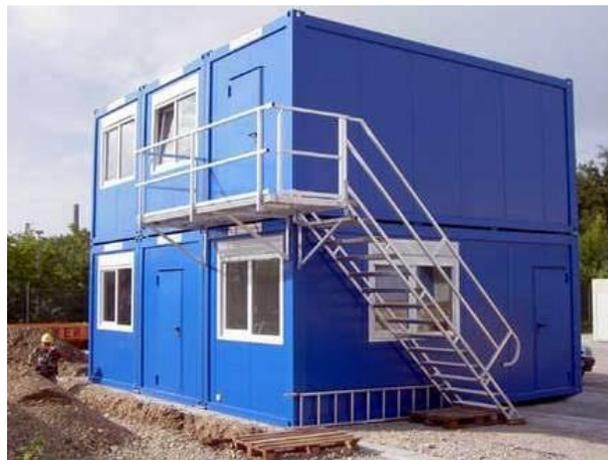
Figura 10 Exemplo de escada e guarda-corpo em contêiner
