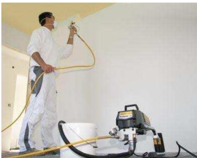
Figura 6 Pintor utilizando mascara inadequada (PFF) para a atividade de pintura por pulverização de tinta.
