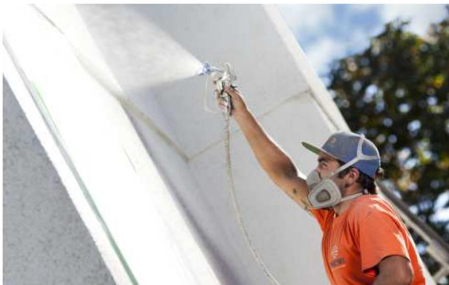
Figura 3 Névoa gerada ao aplicar a tinta por pulverização.
