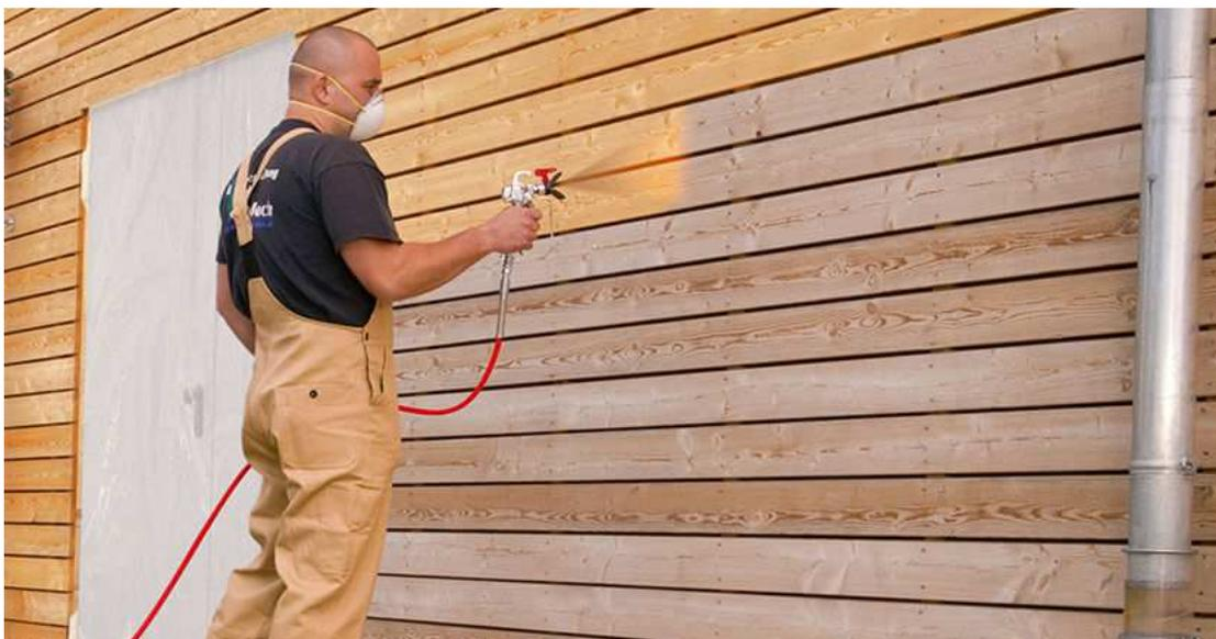
Figura 2 Execução do método de pintura por 'airless'.
