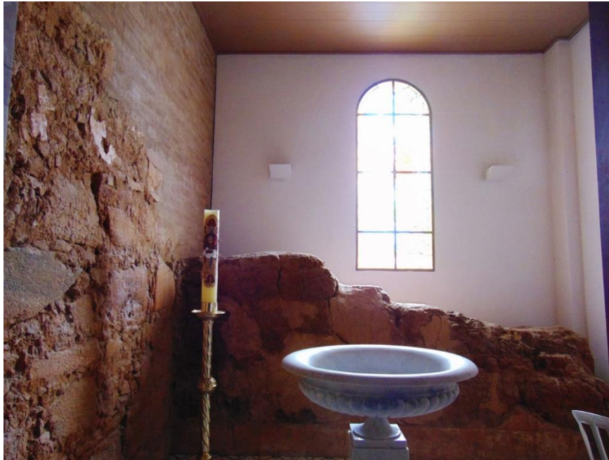
Figura 19 - Na sala de batismo podemos perceber que a parede antiga faz parte no novo cenário da Igreja. Marcas que a grande enchente não conseguiu destruir.
