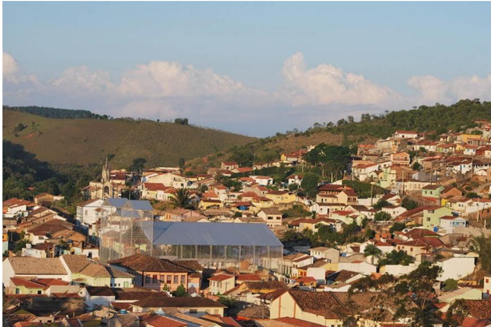
Figura 18 - Estrutura metálica utilizada para proteger os objetos e paredes remanescentes. Erguidas num molde que lembrava o templo que fazia parte do cenário urbano luizense.
