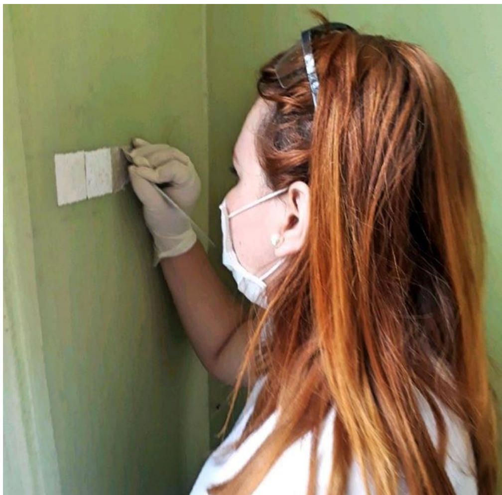
Arquiteta Isabela Pimentel. Prospecção Pictórica no Grupo Escolar Ruy Barbosa para descobrir a cor original Fonte: Arquivo Pessoal
