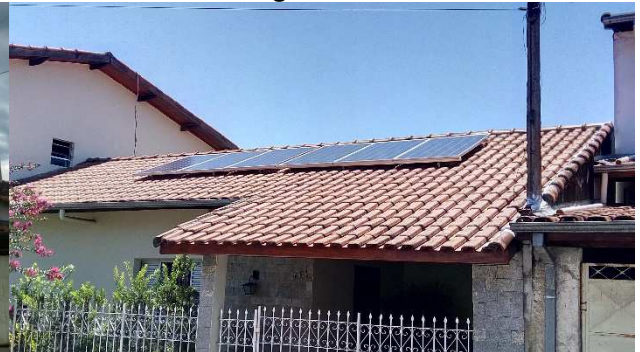
Figura 42b: Painéis Instalados
