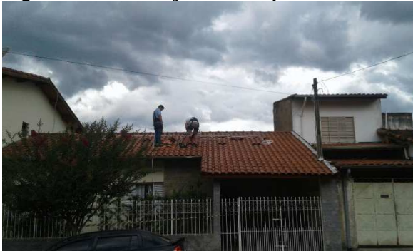
Figura 42a: Instalação dos Suportes
