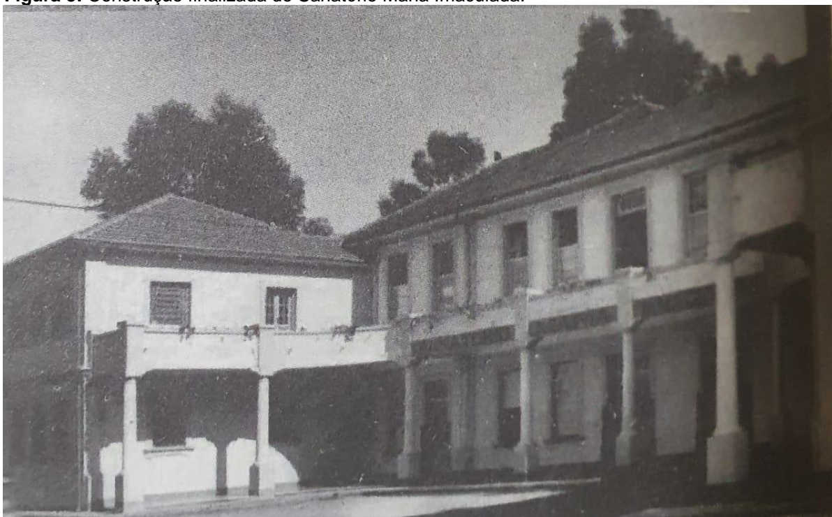
Figura 3: Construção finalizada do Sanatório Maria Imaculada.
