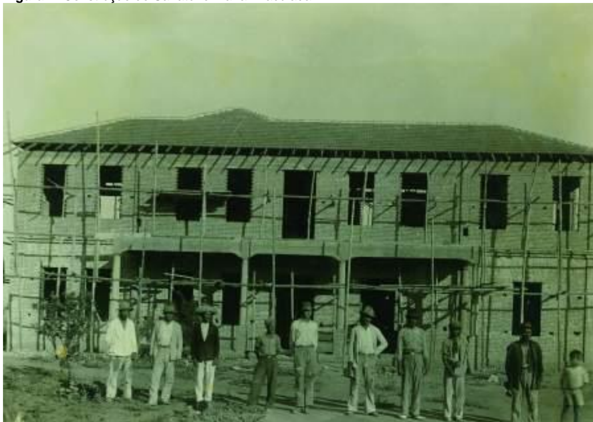
Figura 1: Construção do Sanatório Maria Imaculada.
