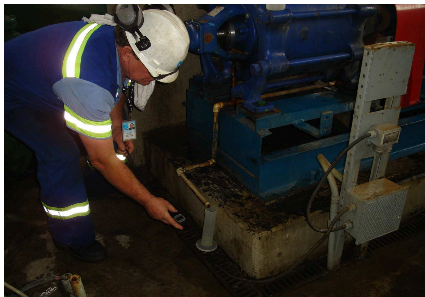
Figura 23: Visão geral da medição de vazamento de água pelas gaxetas (Sabesp, 2008)
