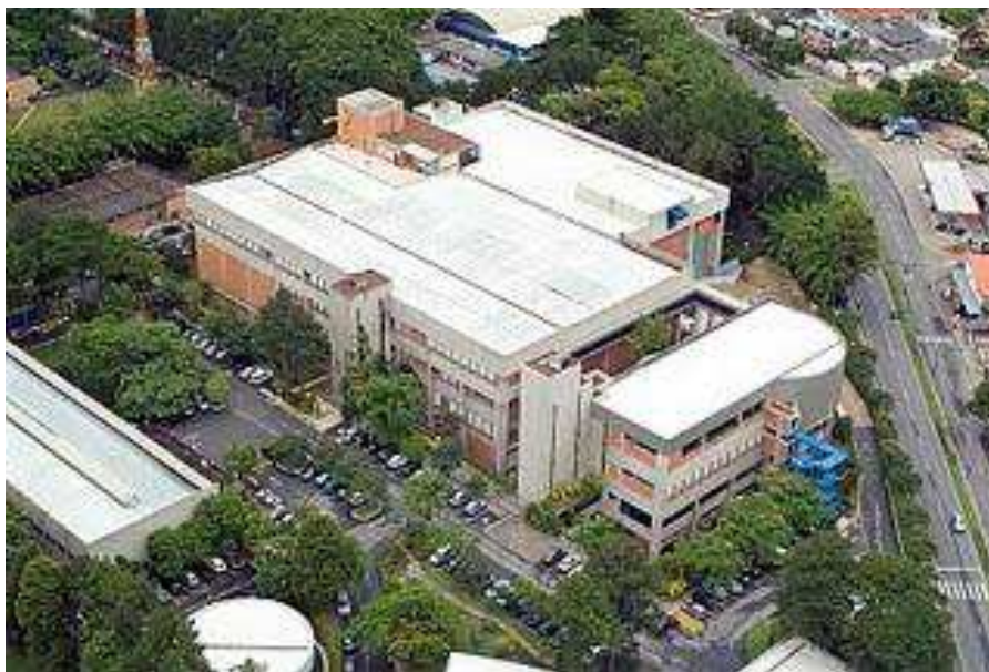
Figura 15: Vista Aérea do Laboratório de Integração e Testes Fonte: CEDOC do LIT
