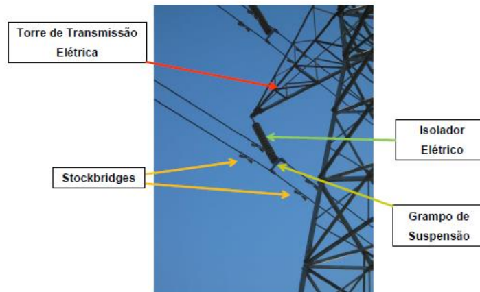
Figura 24: Utilização do amortecedor Stockbridge em uma LT.
