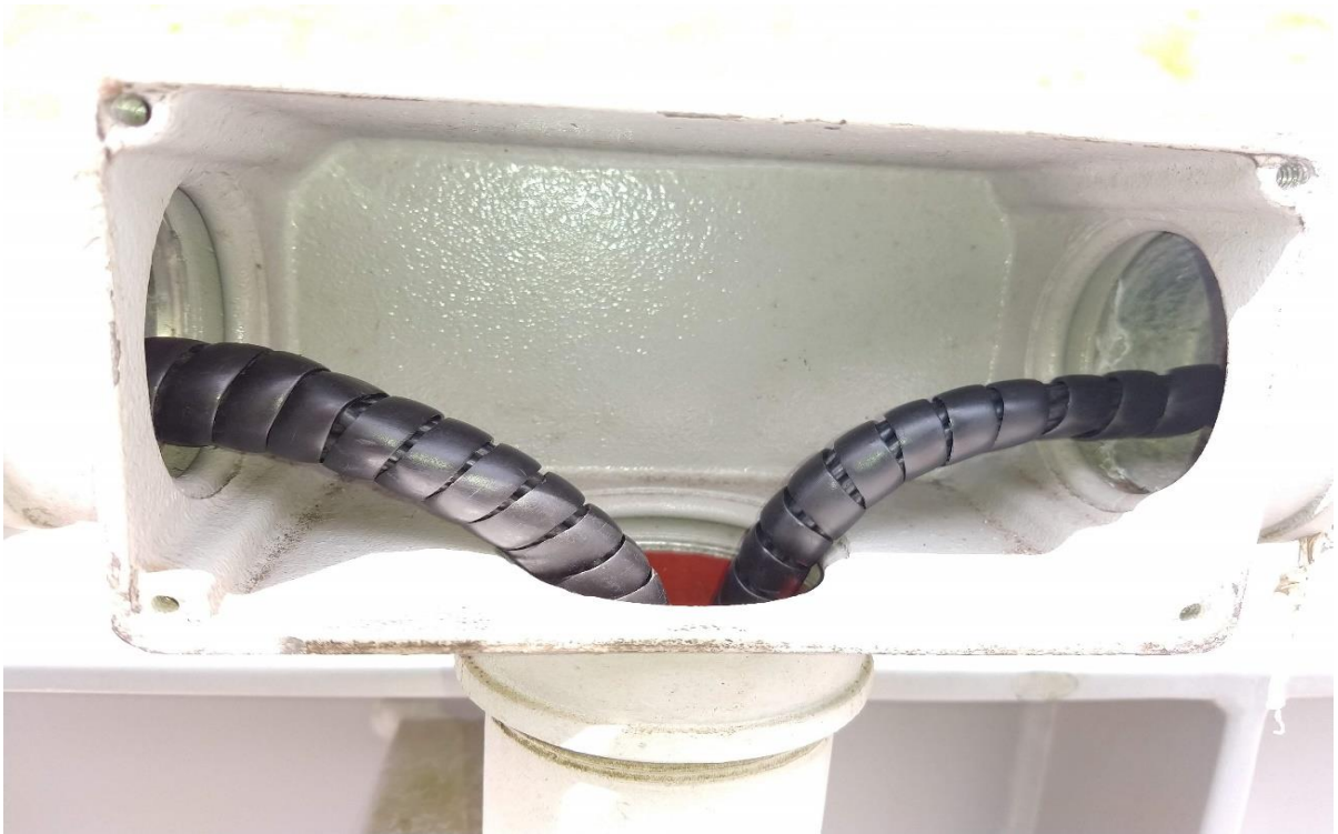
Reator instalado na subestação Taubaté pertencente a área da Copel Geração e Transmissão. Fonte: Próprio autor.
