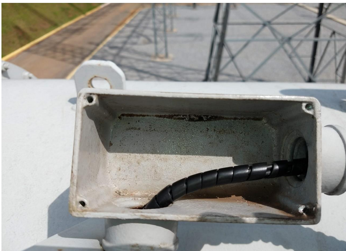
Reator instalado na subestação Taubaté pertencente a área da Copel Geração e Transmissão. Fonte: Próprio autor.
