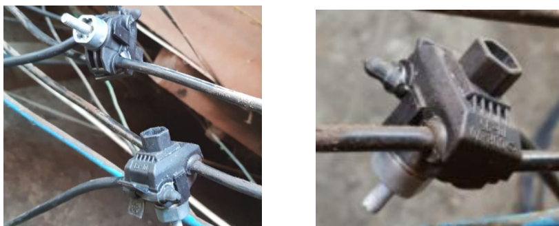
Figura 29: Conexão à rede
