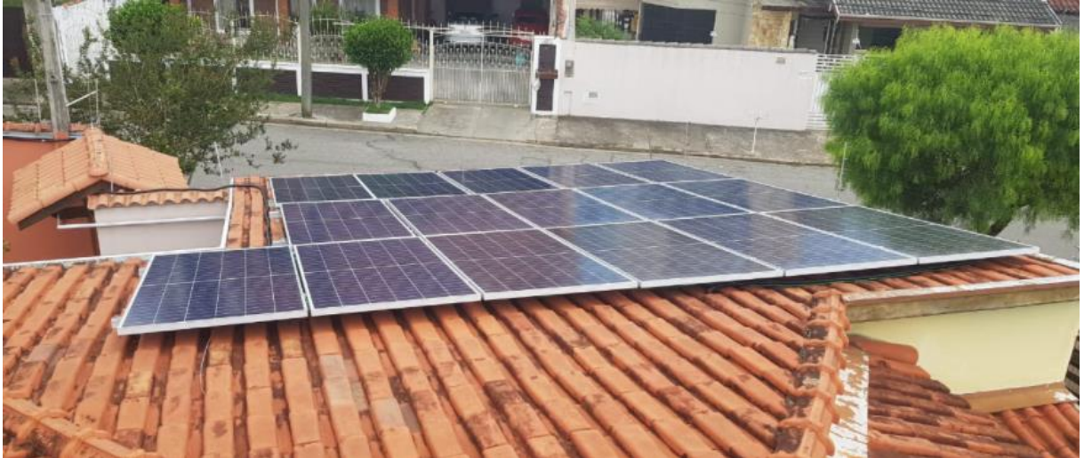
Figura 24: Distribuição dos painéis no telhado
