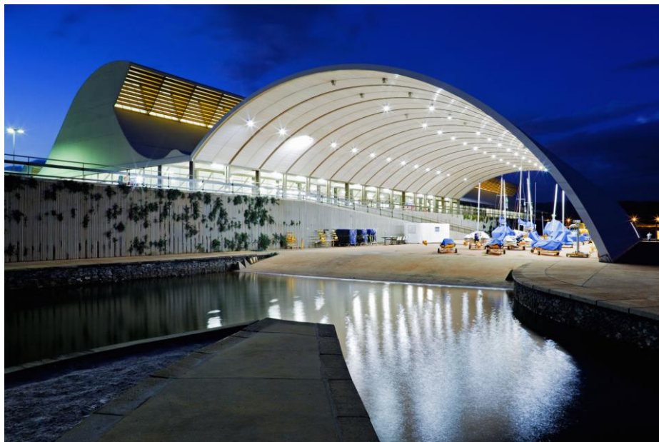
Figura 34 - Vista do edifício Rede SARAH.
