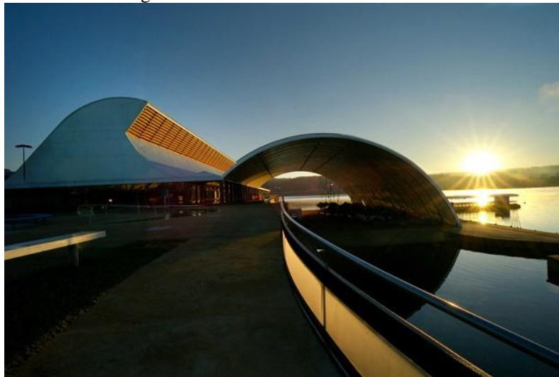
Figura 32. Vista do edifício Rede SARAH.
