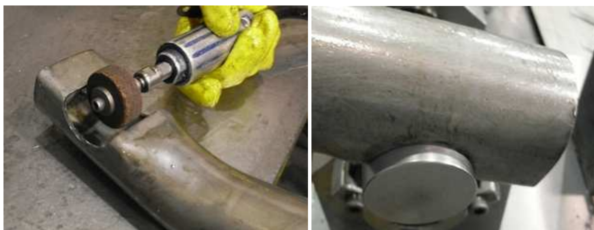
Figura 24 – Operação de rebarbação e verificação.
