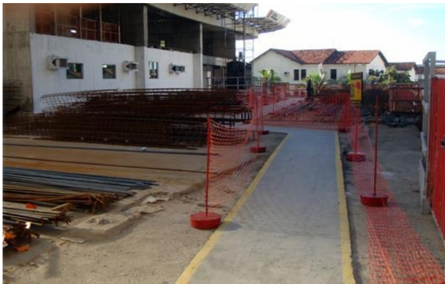
Figura 8 - 5S na organização do canteiro de obras
