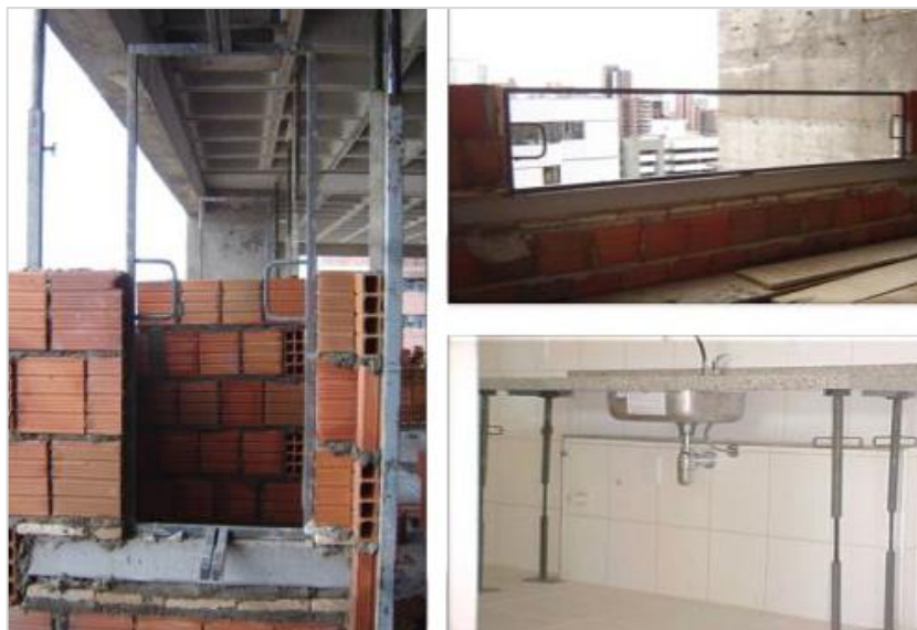
Figura 13 - Poka-yoke de atividades de construção
