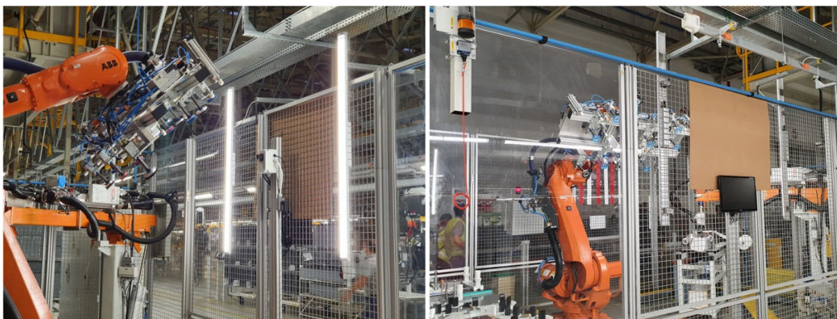
Figura 39 – Luminárias e anteparo instalados para correção da iluminação
