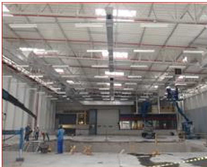
Figura 7 - Construção do PIT Fonte: autor
