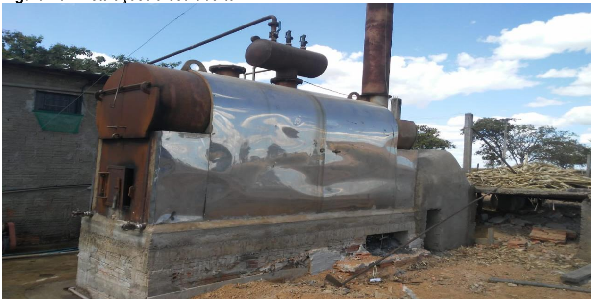
Figura 10 - Instalações a céu aberto.
