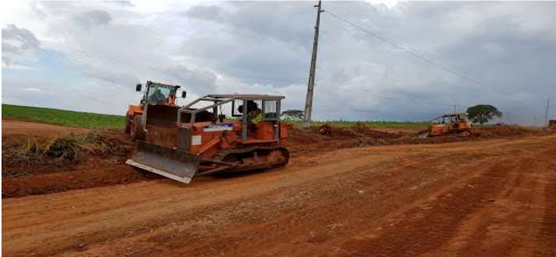
Figura 7 - Serviço de terraplanagem da empresa TW - Mecanização Agrícola Ltda.
