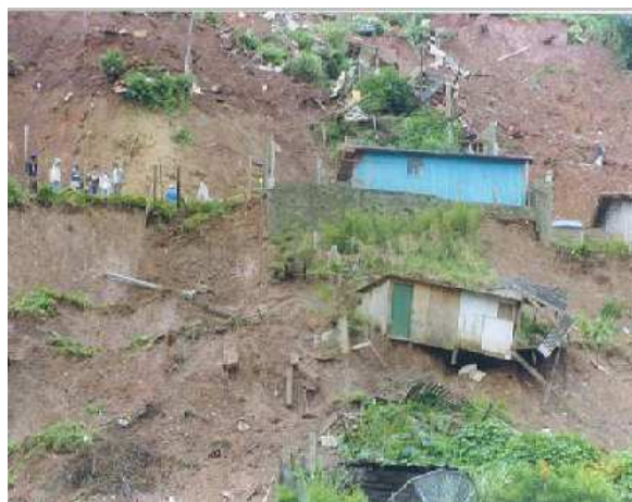
Figura 2 – Detalhe da destruição causada pelos escorregamentos ocorridos no verão do ano 2000, em patamares de corte e aterro no bairro do Britador.
