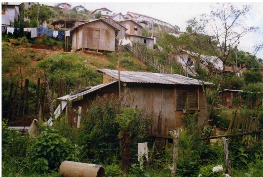
Figura 5 – Habitação precária de madeira, na Vila Santo Antonio. Fonte: Defesa Civil de Campos do Jordão (2007).
