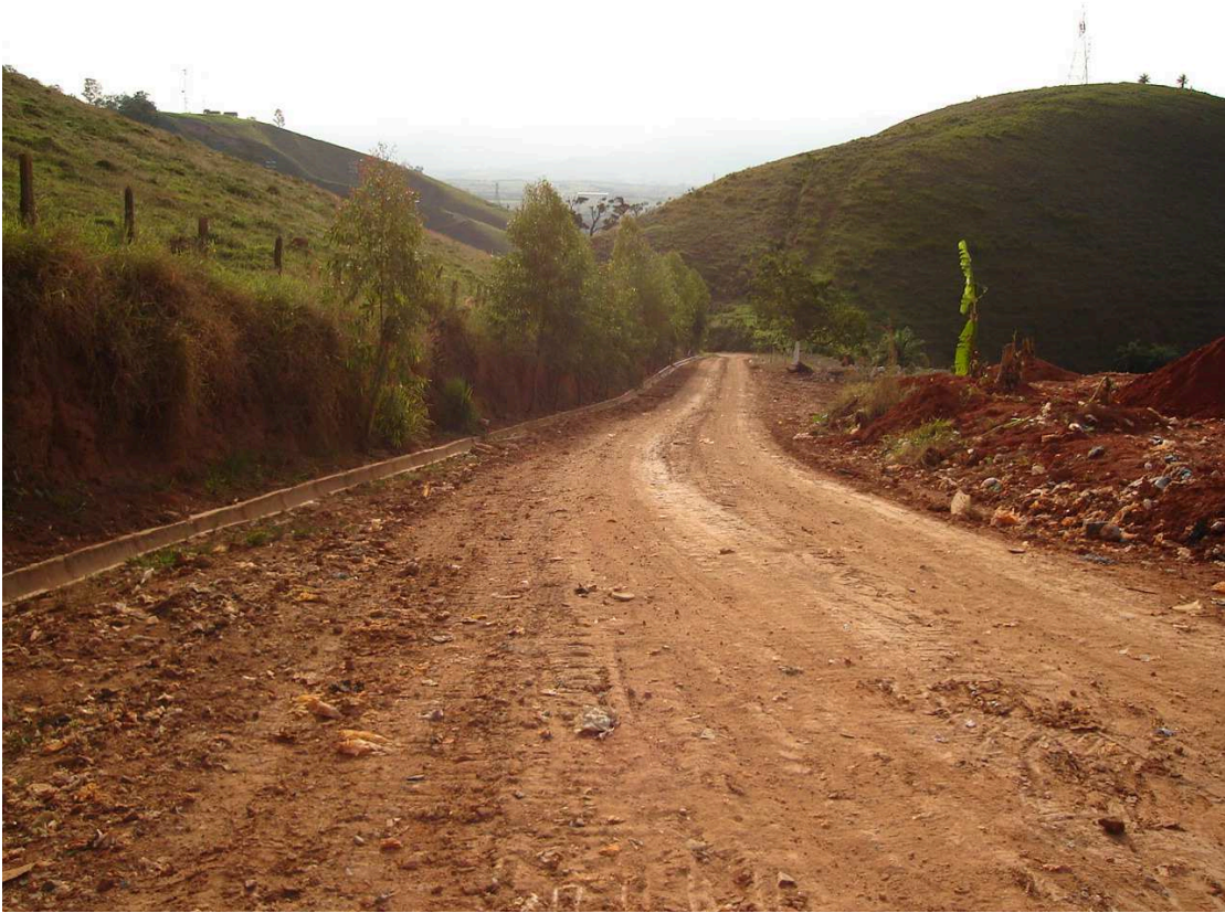
FIGURA 20. ENTRADA DO ATERRO, VALAS LATERAIS.
