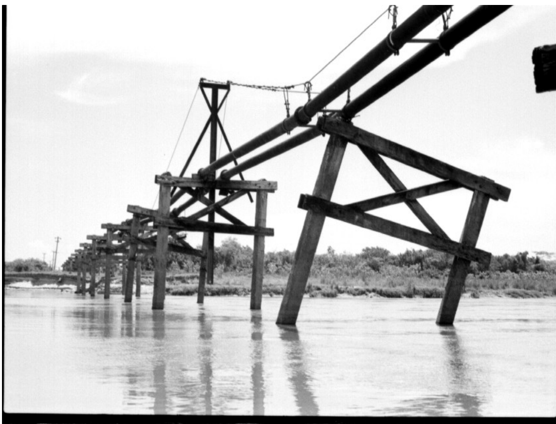
Figura 22 – Adutora da Serra do Poço Grande, Travessia do Rio Paraíba.
