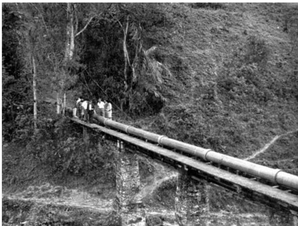
Figura 21 – Adutora da Serra do poço Grande
