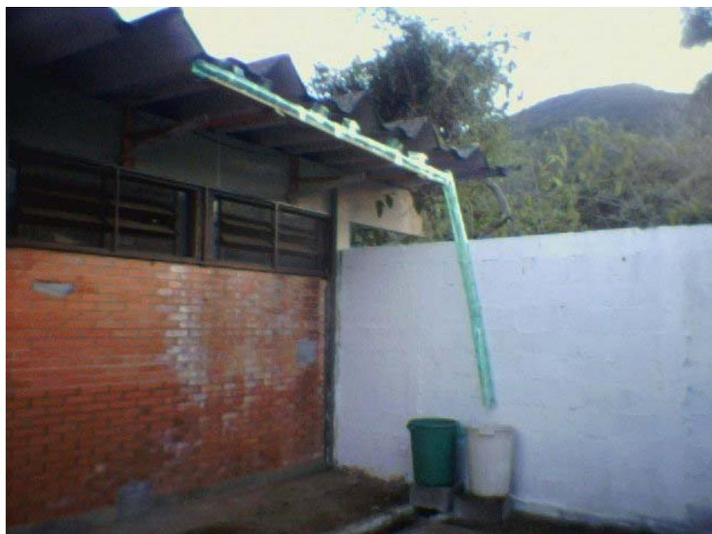
*Figura 19: Calha de PET pronta com recipientes para armazenar água*
