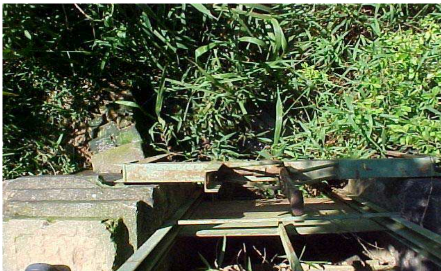
Figura 13. Vista de cima do vertedouro de regularização de vazão da barragem da Maristela. Coordenadas UTM 0437239 e 7463740.
