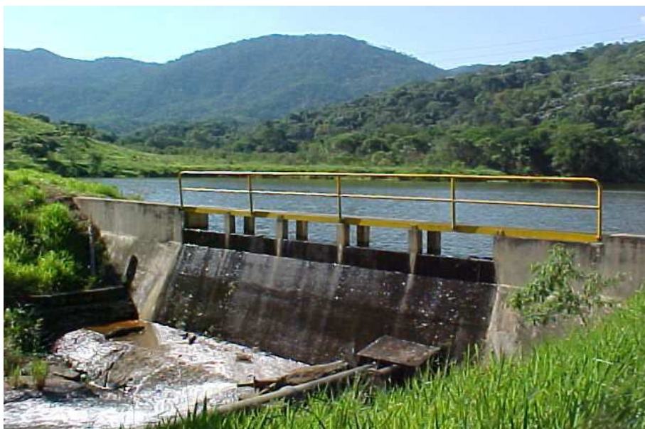
Figura 8. Barragem da Prefeitura-UNITAU, construída para empresa A na serra da Pedra Branca, uma ARIE em propriedade da Universidade de Taubaté. Coordenadas UTM 0432002 e 7461971.
