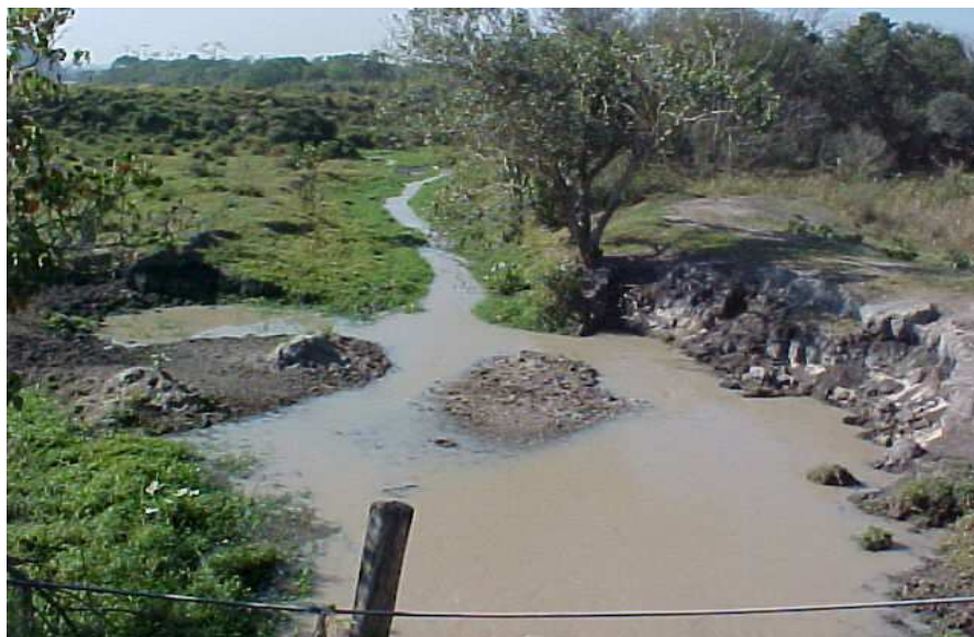
Figura 36. Saída d'água do ribeirão da Serragem para a foz (Paraíba do Sul) vinda do Produtor E. Coordenadas UTM 0439669 e 7461050.
