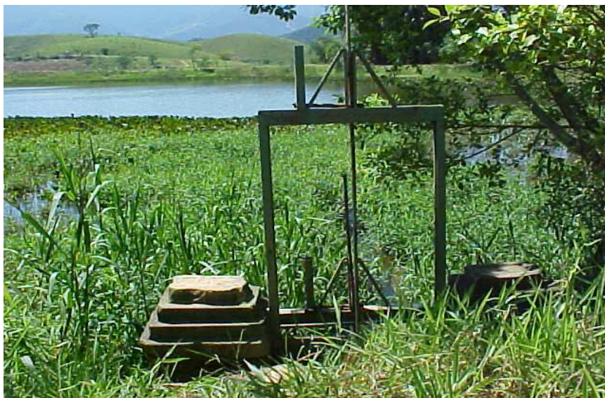
Figura 12. Vertedouro do barramento da Maristela, regularização da entrada d'água na bacia. Coordenadas UTM 0437179 e 7463667.
