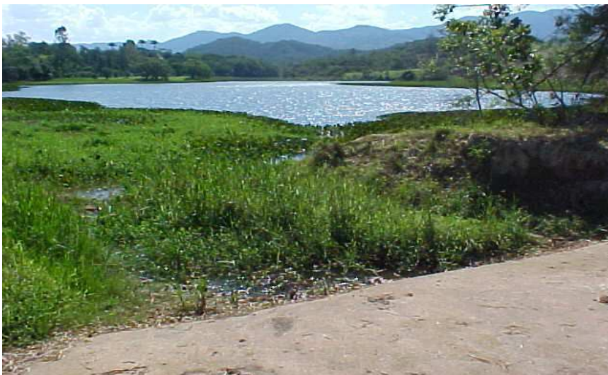
Figura 35. Canal de descarga do escoamento superficial após ultrapassar a cota máxima do volume da barragem da Maristela. Coordenadas UTM 0437205 e 7463689.
