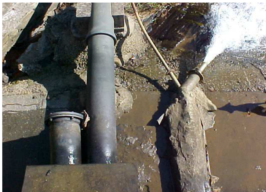
Figura 9. Estruturas que compõem a barragem da Prefeitura-UNITAU, lado esquerdo captação da Empresa A, lado direito descarregador de fundo. Coordenadas UTM 0432002 e 7461971.
