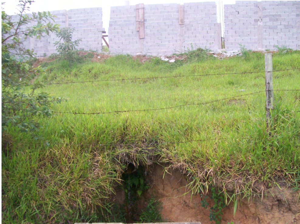
Figura 6. Muro de um condomínio em fase de implantação onde nota-se no barranco a saída de um curso d'água canalizado (margem do ribeirão Itaim) no Bairro do Cataguá.
