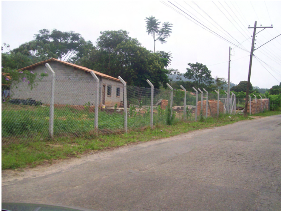
Figura 8. Intervenção em APP para construção de residência (margem do ribeirão Itaim) no Bairro do Cataguá.
