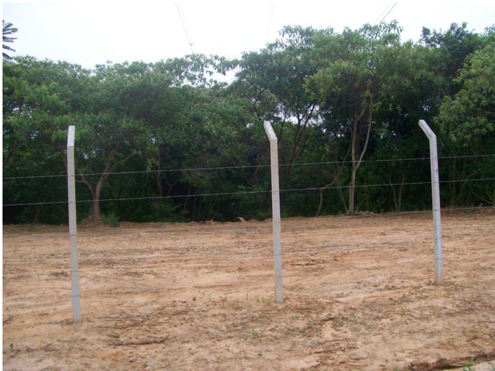
Figura 7. Vista de uma área onde se executou o aplainamento com máquina de terraplanagem, dentro dos limites da APP (margem do ribeirão Itaim) no Bairro do Cataguá.
