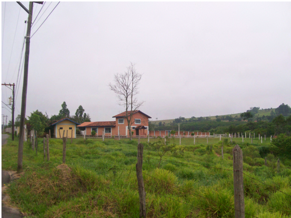
Figura 5. Foto de construção acabada situada dentro dos limites de APP (margem do ribeirão Itaim) no Bairro do Cataguá.
