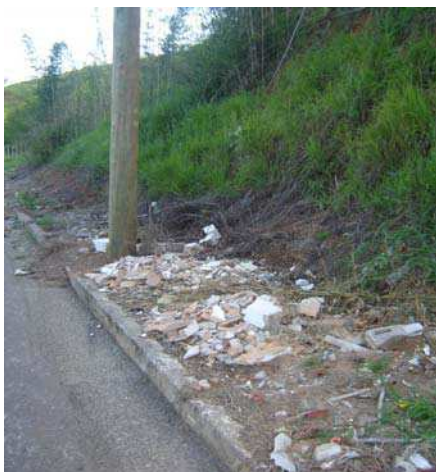
Figura 3 – Entulho no passeio.
