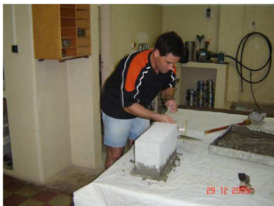
Figura 19 – Execução do capeamento.
