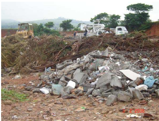
Figura 25 – Entulho descartado em aterro. Fonte: Autor (2005)
