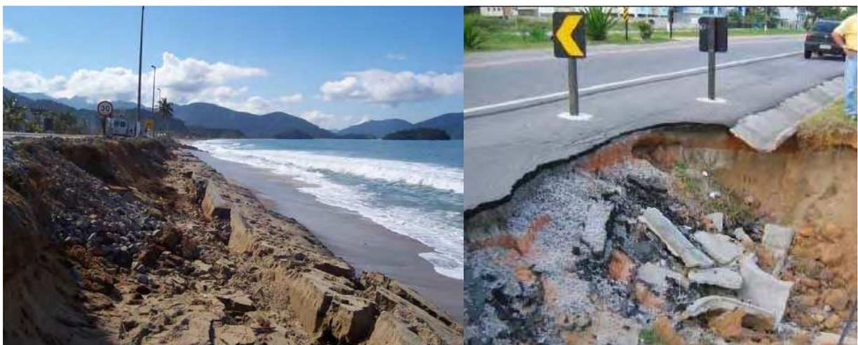
Figura 42 - Efeitos da ressaca de 06 de junho de 2006 na erosão junto à rodovia Rio Santos na praia de Massaguaçu, em Caraguatatuba / SP.
