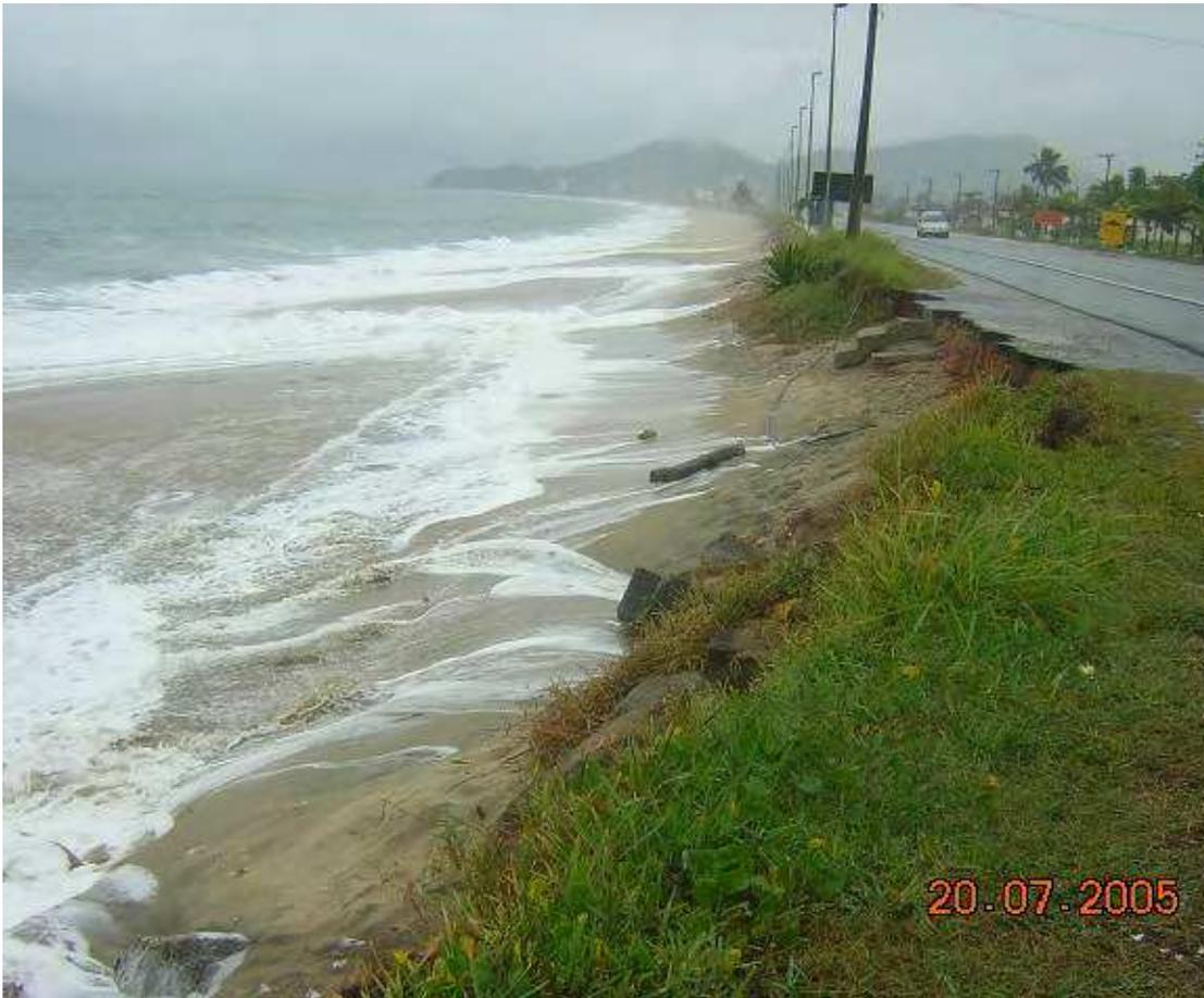
Figura 41 - Efeitos da ressaca de 20 de julho de 2005 na erosão junto à rodovia Rio Santos na praia de Massaguaçu, em Caraguatatuba / SP.
