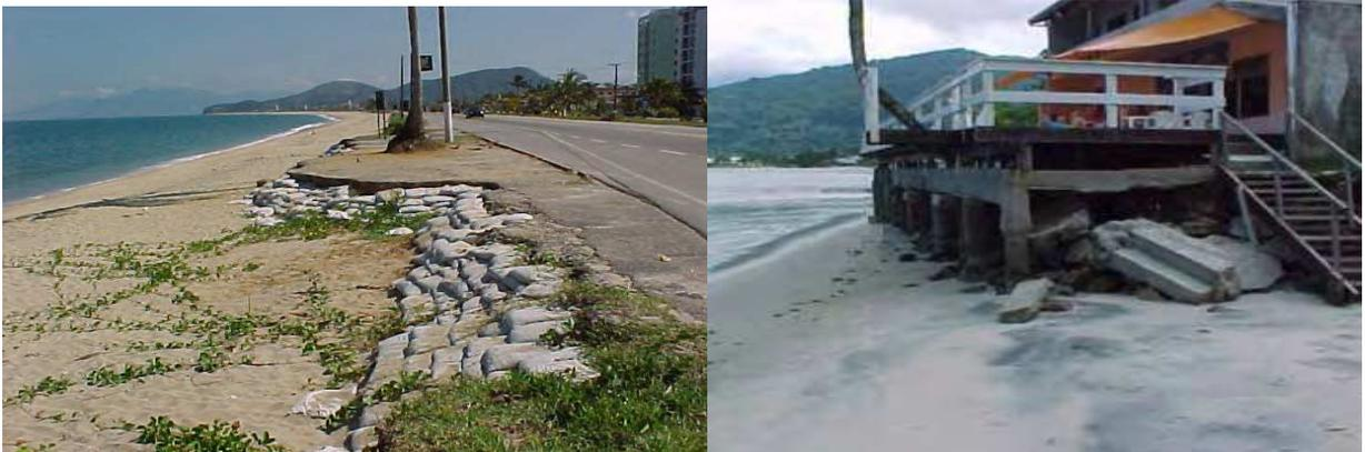
Figura 57 - Destruição de estruturas artificiais construídas sobre os depósitos marinhos ou eólicos holocênicos, a pós-praia, o estirâncio, a face litorânea e/ou a zona de surfe
