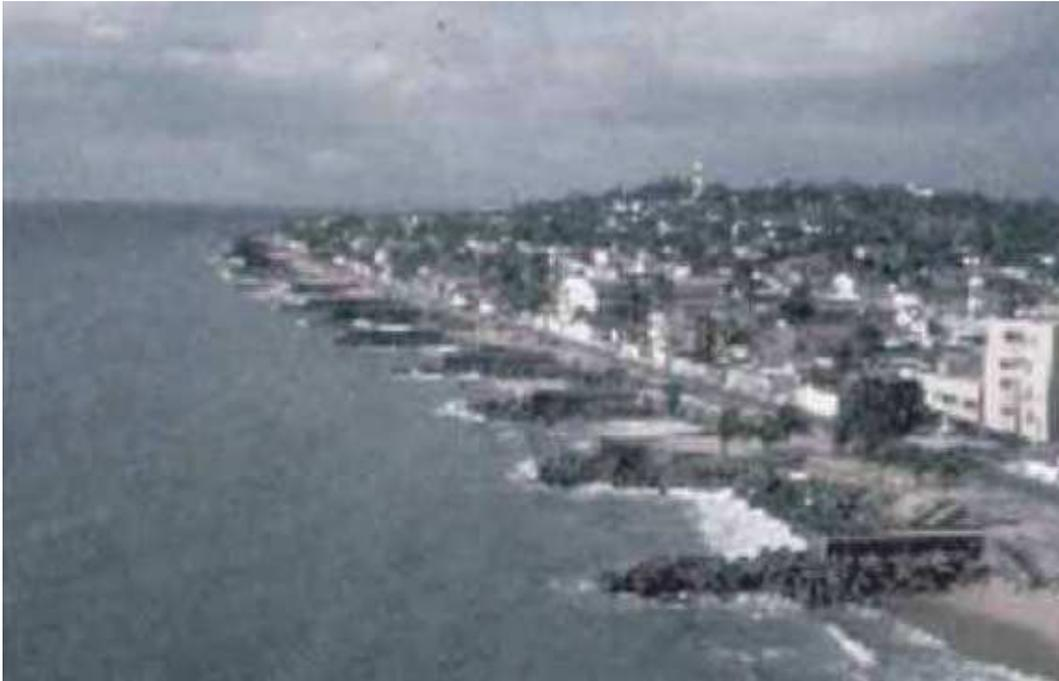
Figura 32 - Espigões construídos na praia em Olinda / PE.
