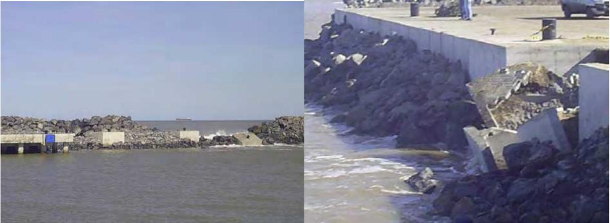
Figura 43 - Efeitos da ressaca de junho de 2006 no colapso do enrocamento do molhe de barcaças da CST, em Vitória / ES.
